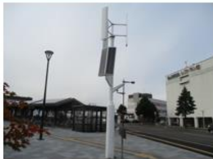
太陽光風力発電式街路灯 (避難施設等の敷地内)
